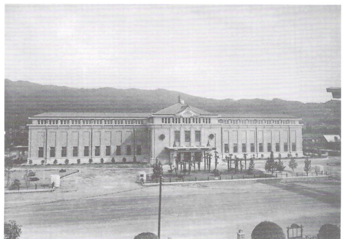
創建当時の本館外観
