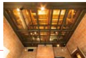
小屋裏と煉瓦壁
