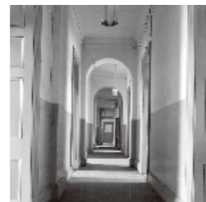
昭和期の2階南側廊下
