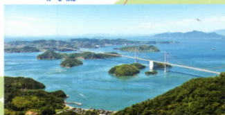
来島海峡大橋
