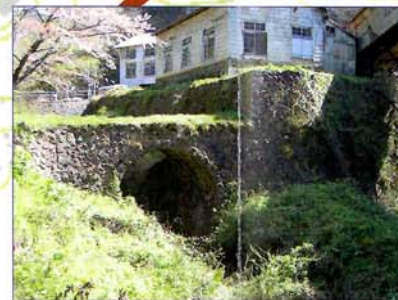
石積アーチ橋
