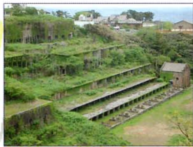
浮遊選鉱場・精錬所跡
