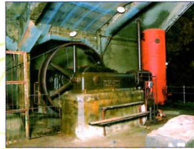
大立堅坑・空気圧縮機
