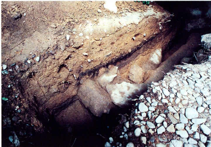
トレンチ掘削後の土層面②
