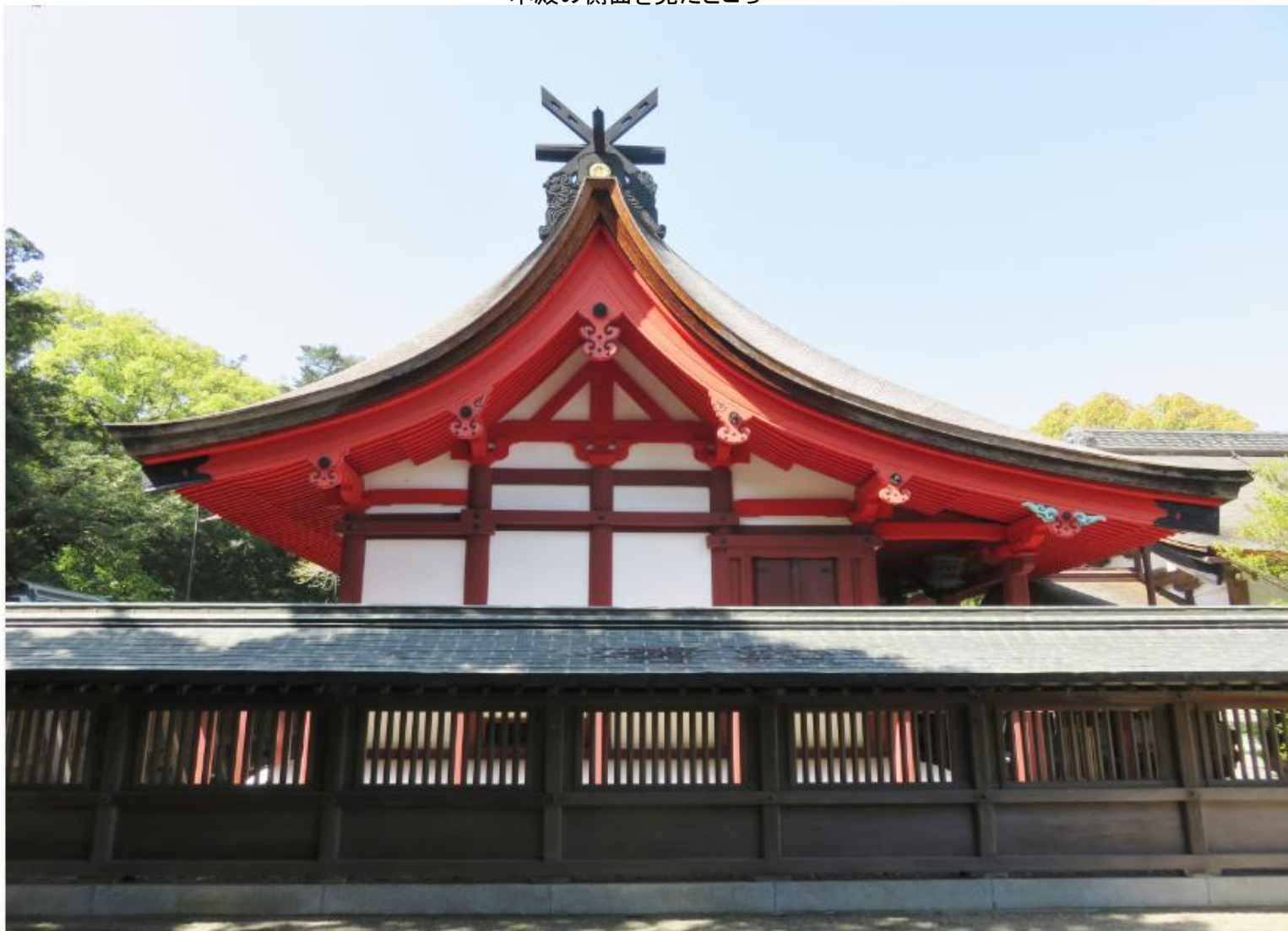
本殿の側面を見たところ
