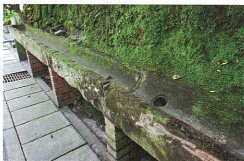
井戸水を使って、顔や手を洗っていた昔の洗面所。当時は湿気で建物が傷むのを防ぐため、洗面所やトイレなどを外に造っていた。
