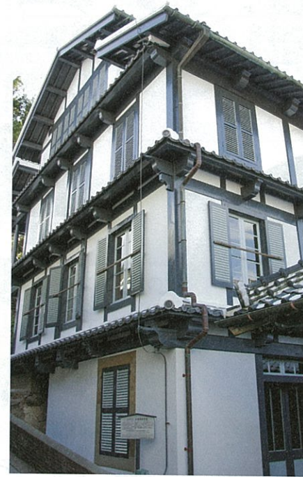
構造は、骨になる木材をレンガではさみこんだ木骨レンガ造り。建築に秀でたド・ロ神父の代表作のひとつで、極めて堅牢。100年以上を経た現在でも使用に耐え、1992年に国の重要文化財に指定された。
