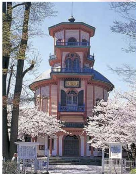
6 山形市郷土館(旧済生館本館) 明治11年(1878)に県立病院「済生館」として建築。3層楼の擬洋風建築で、昭和41年(1966)に国重要文化財に指定。昭和44年(1969)に現在地に移築、昭和46年(1971)に「山形市郷土館」として開館。
