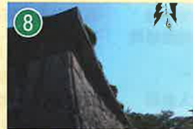
8 石垣 せきかき (はねだし石垣 はねだしいしがき (武者返し むしゃがえし))
